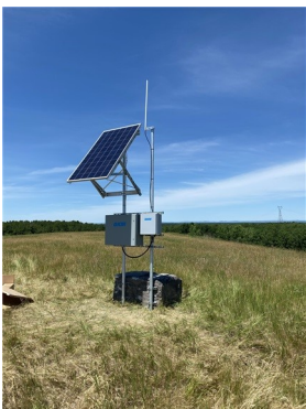
La passerelle RDMS pour ce site ainsi que pour d'autres sites de nos clients
