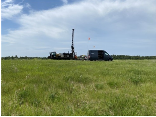
Forage clé en main, essais géotechniques, échantillonnage et installation d'instruments
